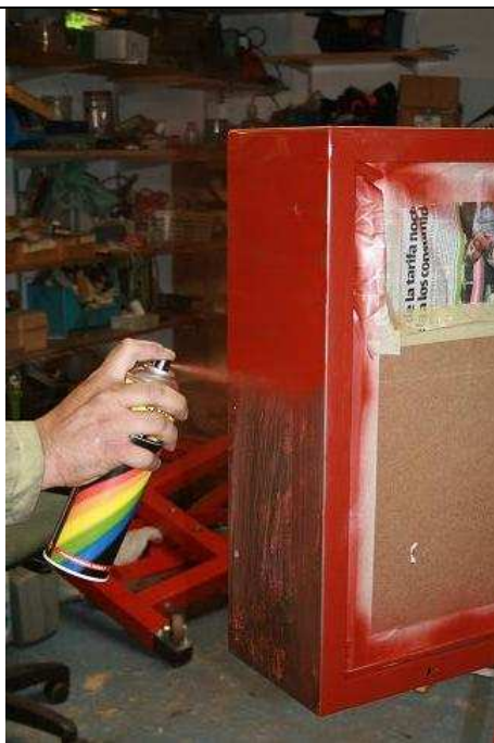
3. Imprimado a spray del bastidor
