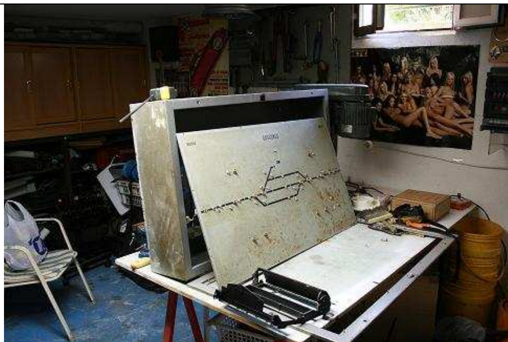
2. Inicio de los trabajos desmontando el cuadro.
